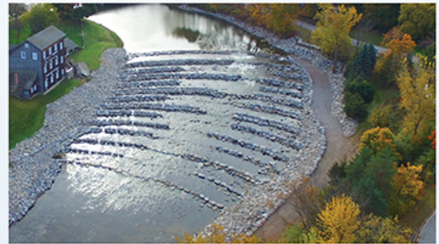
Rock Ramp - Frankenmuth, Mich.
